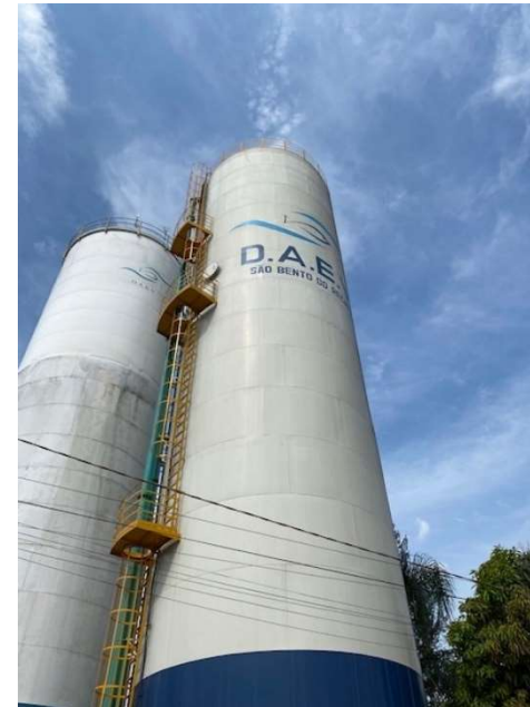
Reservatório São Bento do Recreio (600 m3)
