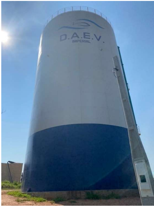
Reservatório Imperial (1.330 m 3 ) – Não Interligado
