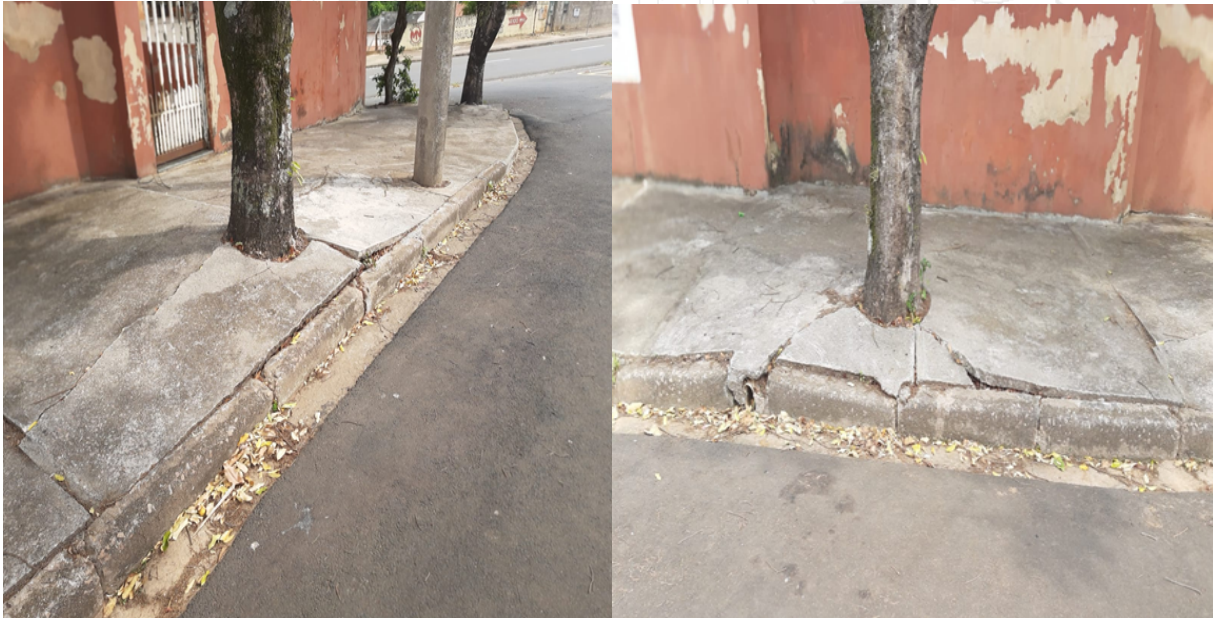
Levantamento e trincas no asfalto.
