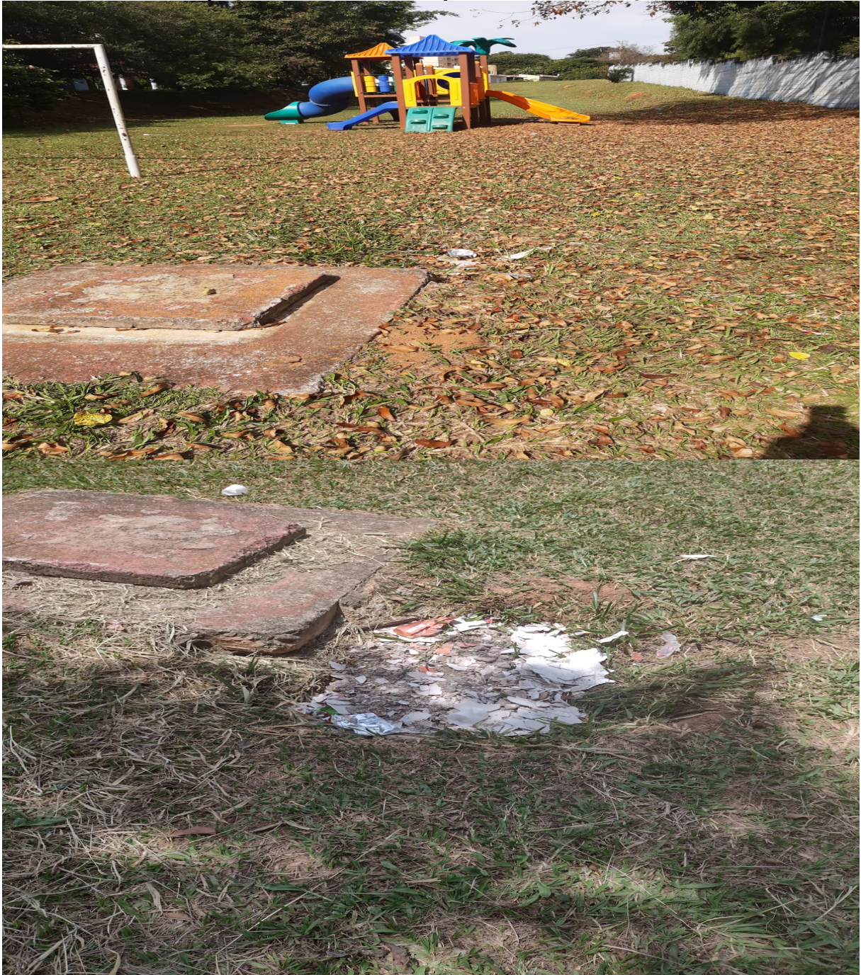
Caixa de inspeção ao lado do Parque Infantil na Praça Luiz Cecco.
