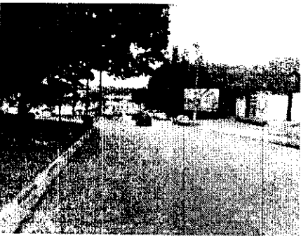
Vista da aproximação da Av. Invernada (Sentido Centro → Bairro) Data: 10/05/2019
