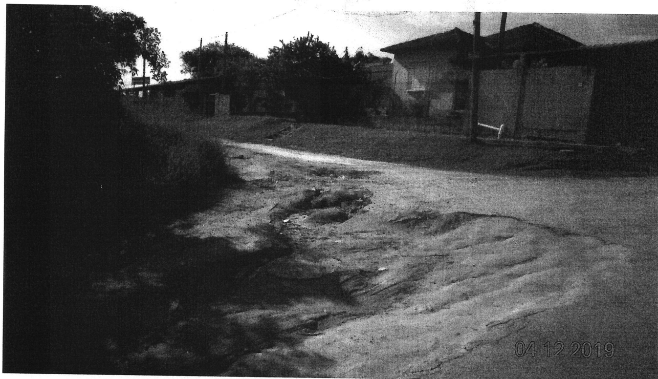
Foto 06 - Rua Itatiaia esquina com a Av. Itatiba (Data - 12/04/2019)
