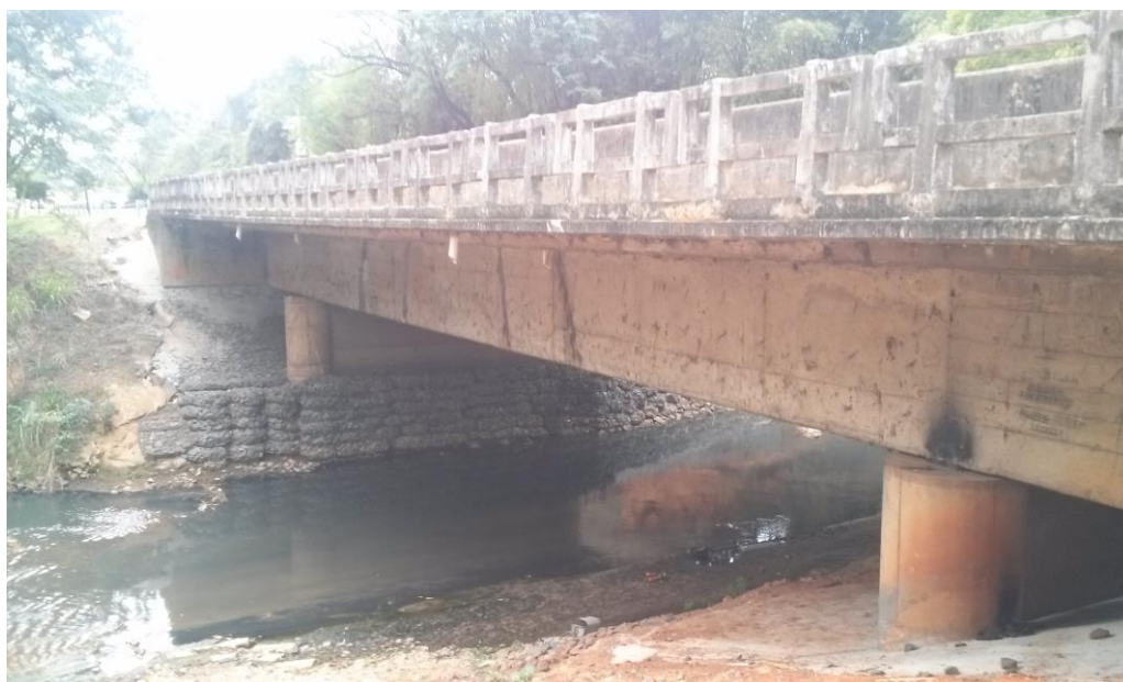
Foto 1 – Ponte existente sobre o ribeirão dos Pinheiros – Gabião na margem direita
