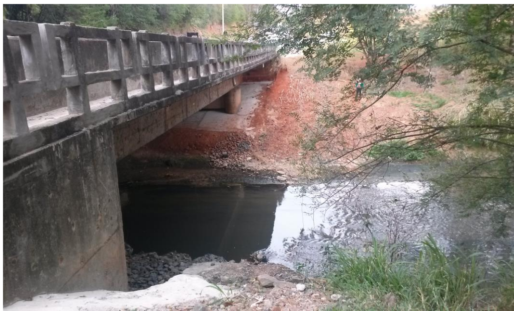
Foto 2 – Ponte existente sobre o ribeirão dos Pinheiros – Vista da margem esquerda
