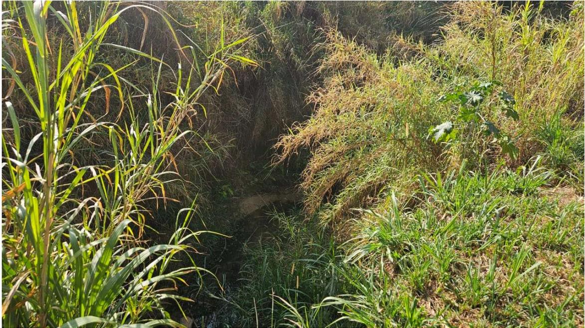
*Foto 5: Detalhe da erosão de fundo afetando as margens, devido o acentuado desvível longitudinal.*
