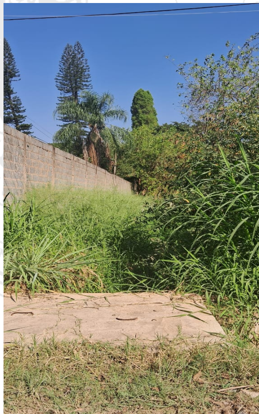
(Vieleira entre 24/lote 21 e a casa nº22)
