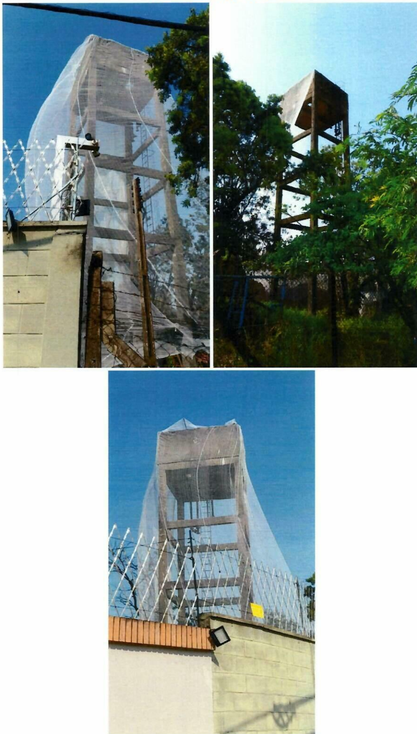
Reservatório elevado em demolição no Alto da Colina, ao lado do Condomínio Cerejeiras
