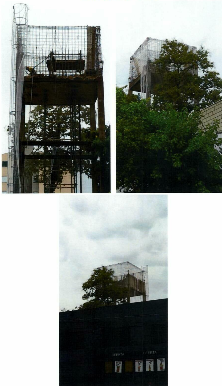
Reservatório elevado em demolição no Parque Florence
