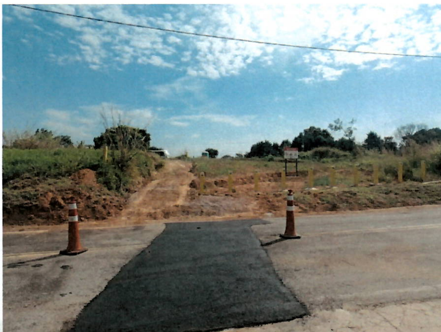
3- Foto do recapeamento - Vistoria em 19/07/2023
