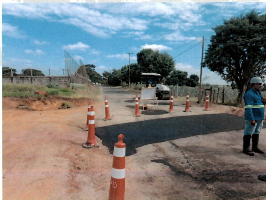
2- Foto do recapeamento - Vistoria em 19/07/2023
