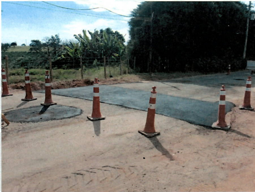
1- Foto do recapeamento - Vistoria em 19/07/2023
