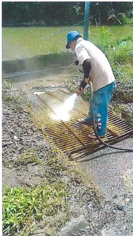
Foto 10 - desobstrução de tubulação de águas pluviais
