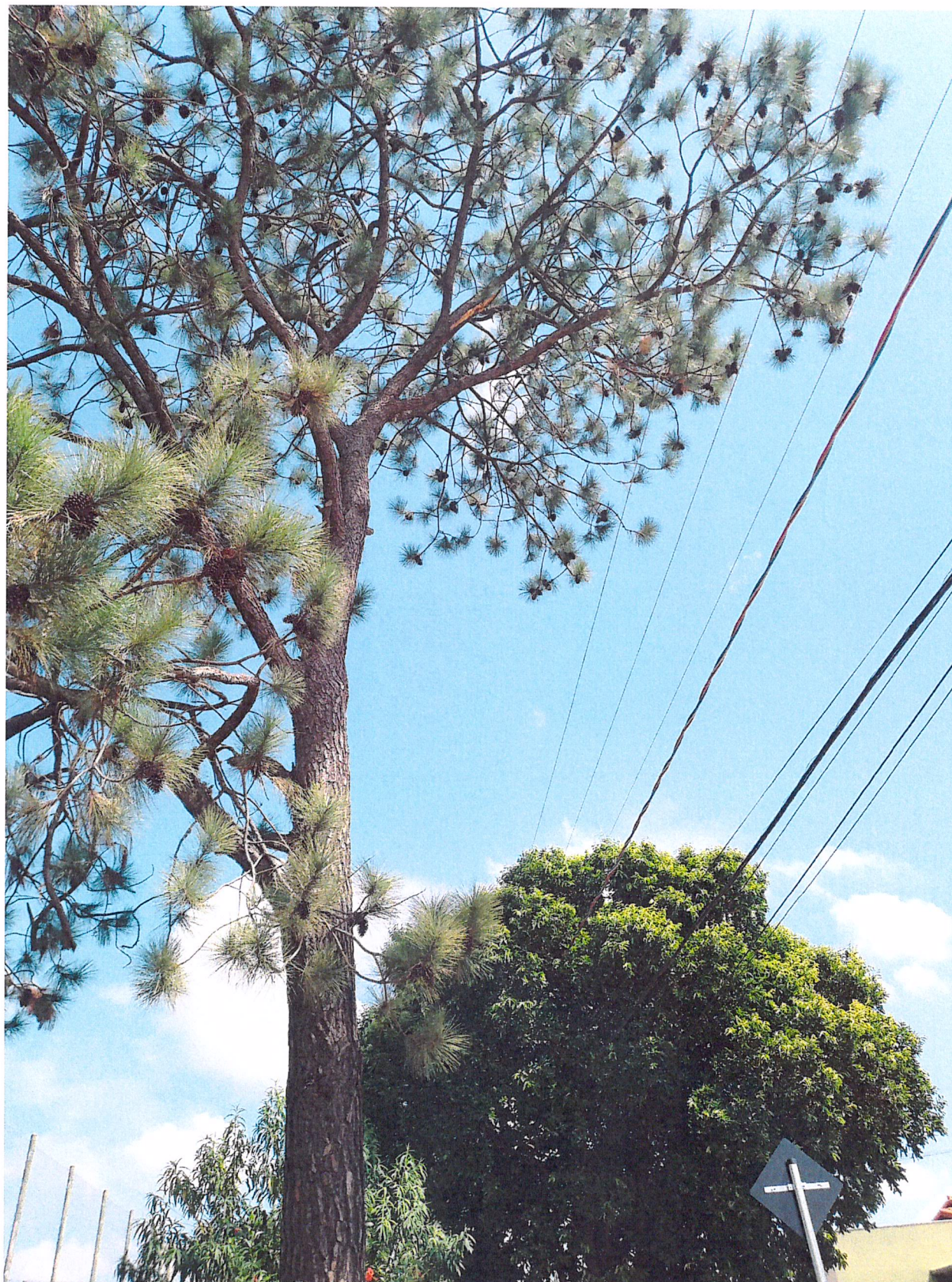
Figura 5: Rede primária próxima (Rua Horácio Amaral)
