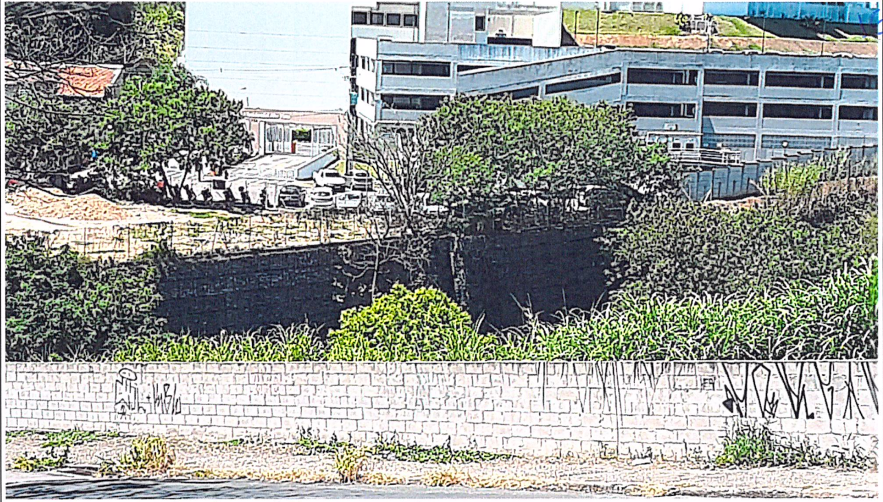
Foto 09: vista externa lateral esquerda (muro contenção)
