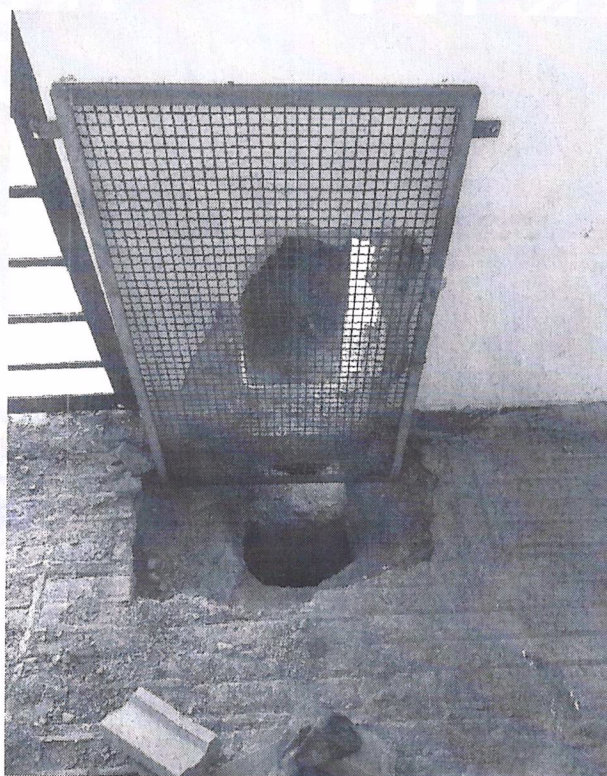
Foto serviços iniciados e paralisados.
