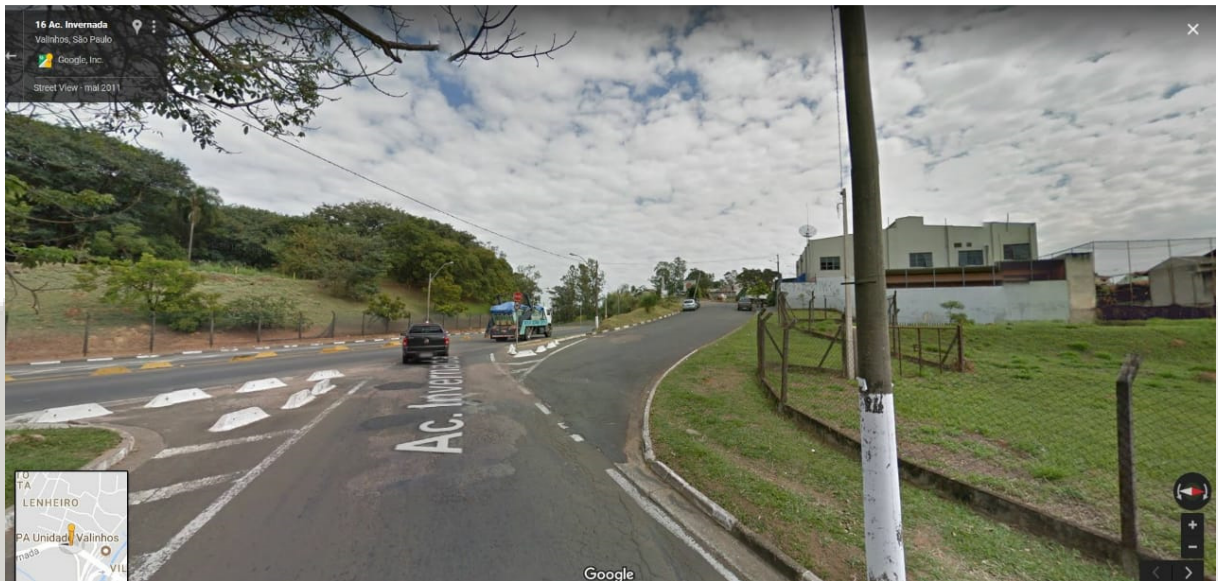
LOCAL ANTES DAS OBRAS
