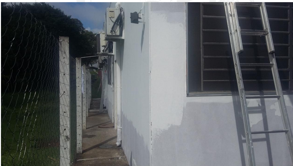
Início de pintura externa nos fundos da edificação
