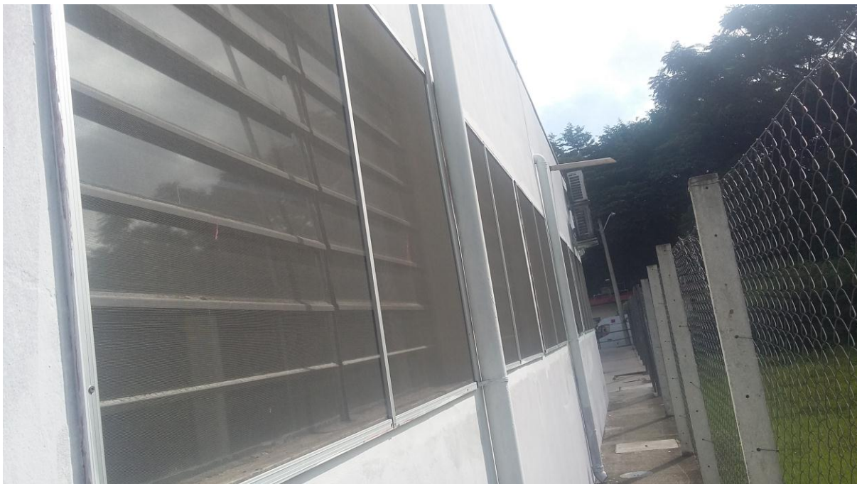
Início de pintura externa nos fundos da edificação - corredor
