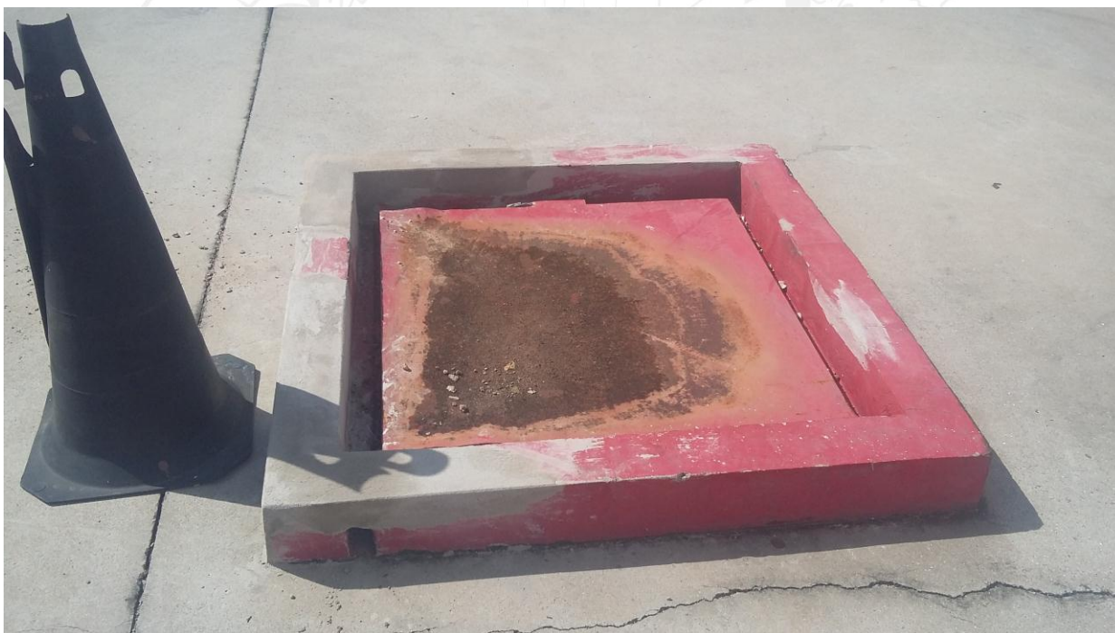
Manutenção de guia de proteção do alçapão – Térreo
