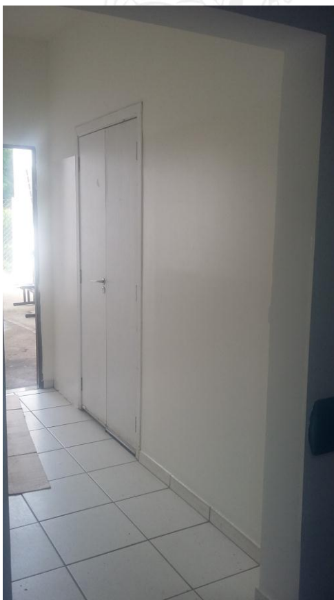
Pintura do corredor de circulação 2, já com a Barra Impermeável, falta acabamento nos rodapés – Térreo
