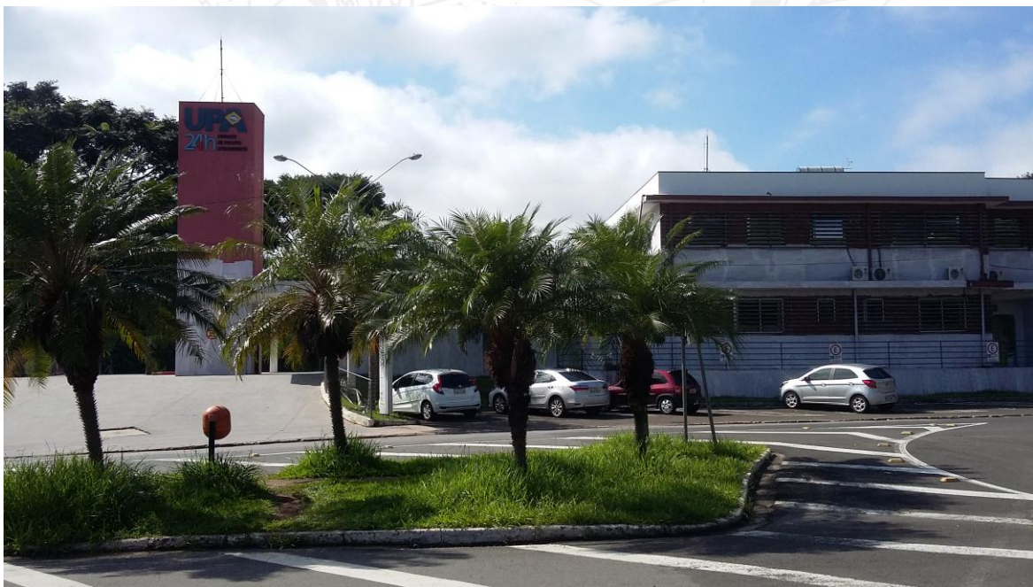
Início de pintura da Fechada
