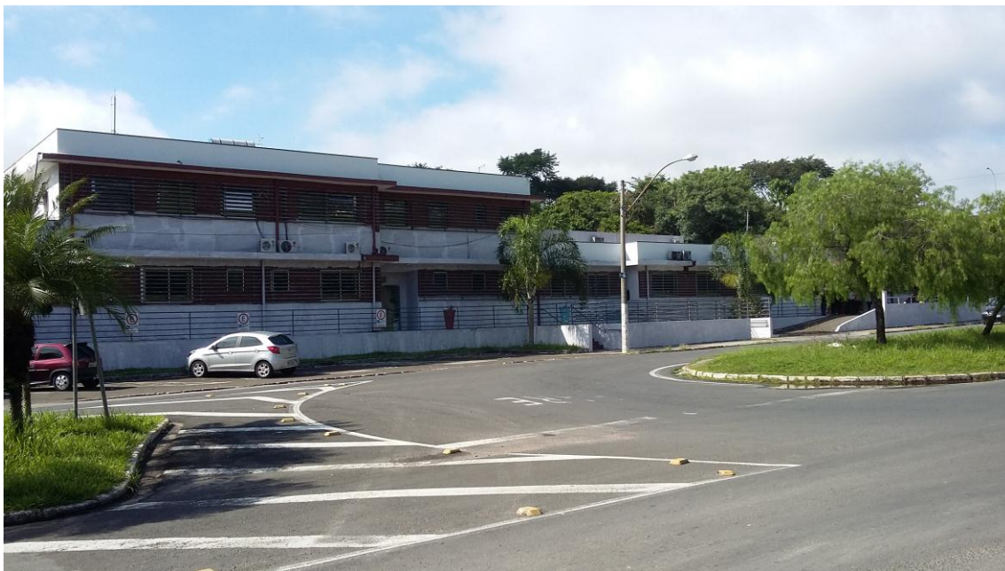
Início de pintura da Fechada
