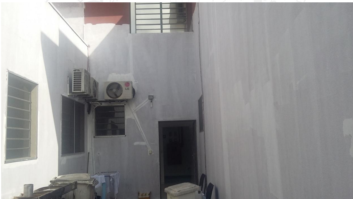
Início de pintura externa nos fundos da edificação em frente ao DML
