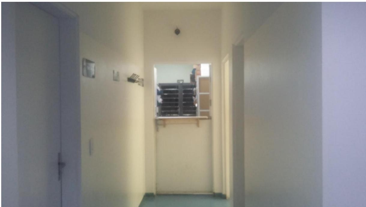
Pintura do corredor de circulação 3, sentido almoxarifado, já com a Barra Impermeável – Térreo
