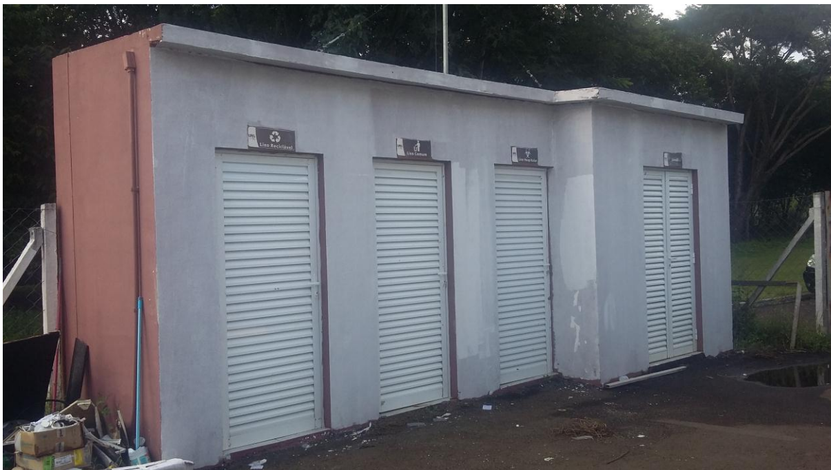
Início de pintura e manutenção das portas de alumínio – Abrigo de Resíduos
