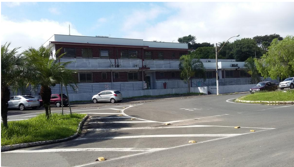
Início de pintura da Fechada
