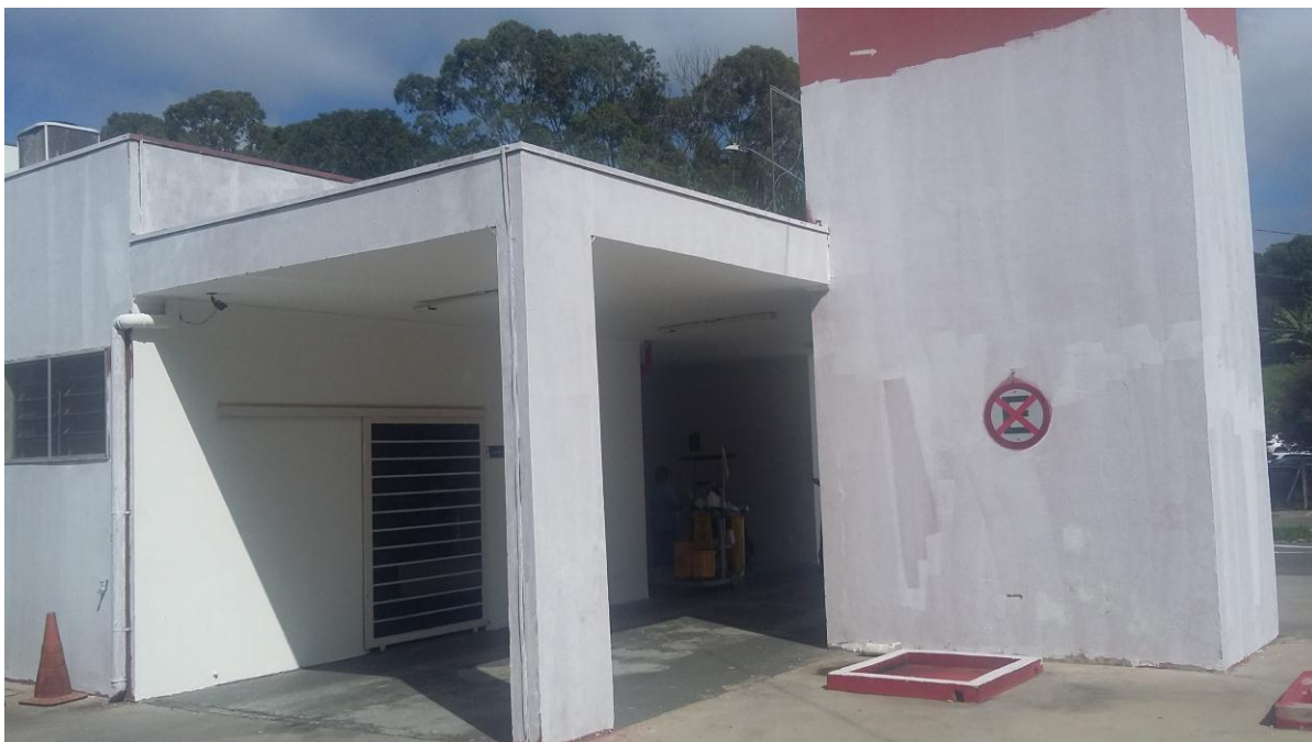
Início de pintura externa nos fundos da edificação – Térreo
