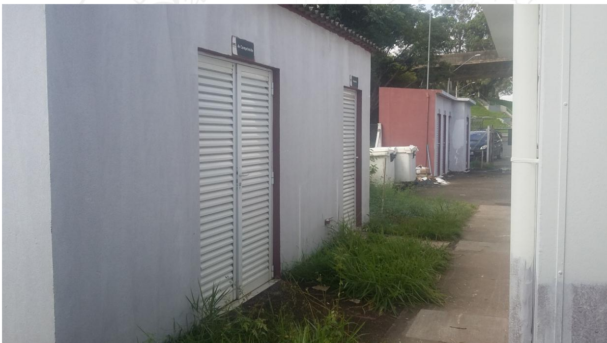
Início de pintura externa nos fundos da edificação e manutenção das portas de alumínio – Abrigo de Resíduos
