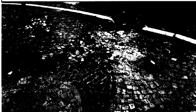
Calçada da Av. dos Esportes x Av. Joaquim Alves Correia - Valinhos - SP - Foto de 17.07.2018
