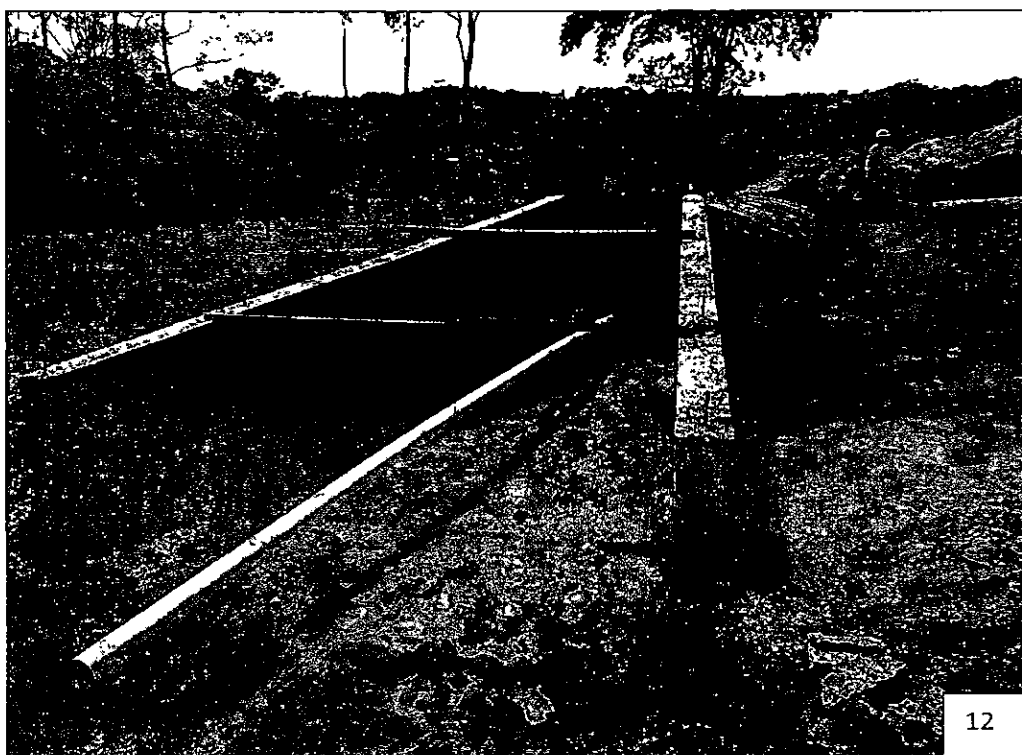
Foto 11 e 12: Detalhe da galeria de águas pluviais sendo executada. A obra auxiliará na captação de águas superficiais.
