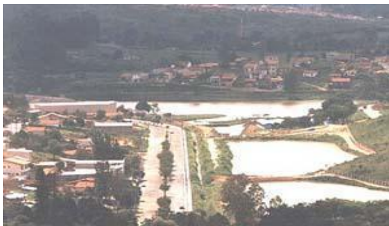
Figura 8: Barragem das Figueiras, capacidade de armazenar de 100 milhões de litros de água.
