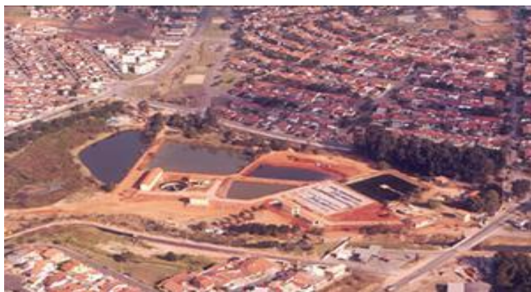
Figura 7: Estação de tratamento de Esgoto - ETE Capuava
